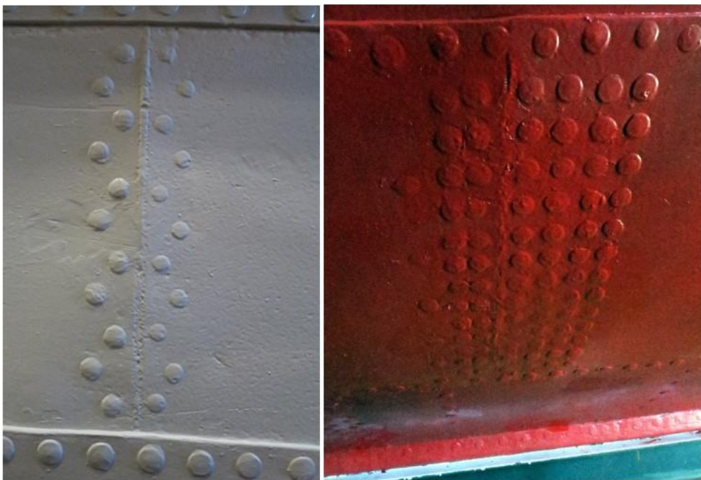
Platestøtene var klinket på uvanlige måter på Bjoren. De enkle laskene var klinket i sikksakk (bildet til venstre). Sikksakk-klinken her har mindre nagler på den ene siden, som må være den eldste. Flere laskeplater var plassert inntil spant, som ga begrenset plass for laskeplaten ved siden av (bildet til høyre).
